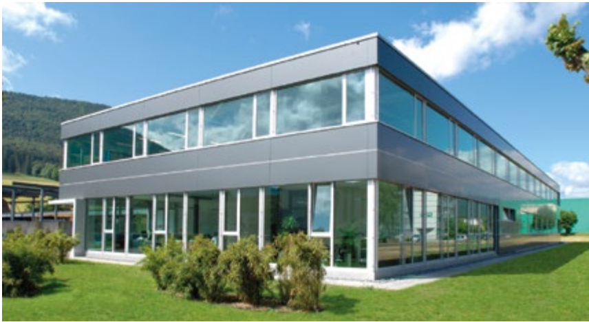
Nuestros contadores son fabricados en unas modernas instalaciones de 1500 m 2
